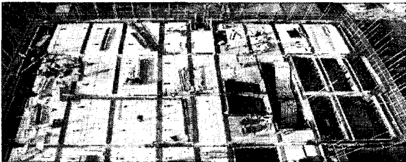
그림 7. 시험 시공 현장 전경
