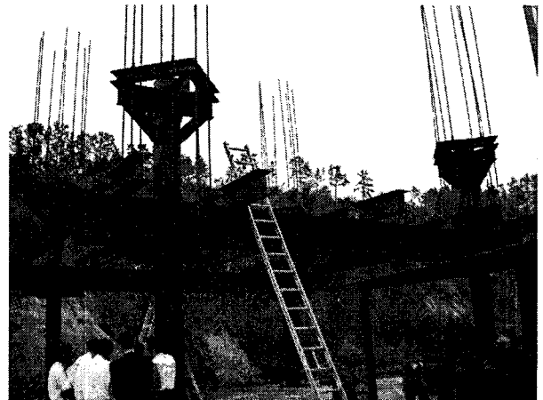
사진 3. 상하분리형 무지주 역타설 거푸집 시험 시공 장면
