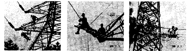
〈그림 9〉 폴리머애자 공사용 장비의 현장적용시험
