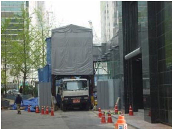
그림 6. Winch Tower 전경
