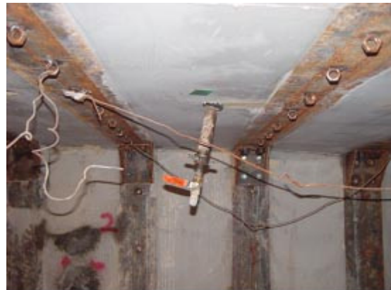
그림 14. Backfill 그라우팅 전경
