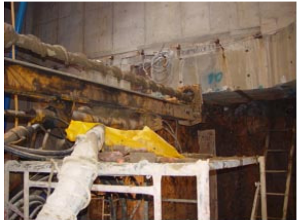
그림 5. 수평강관다단 그라우팅 시공
