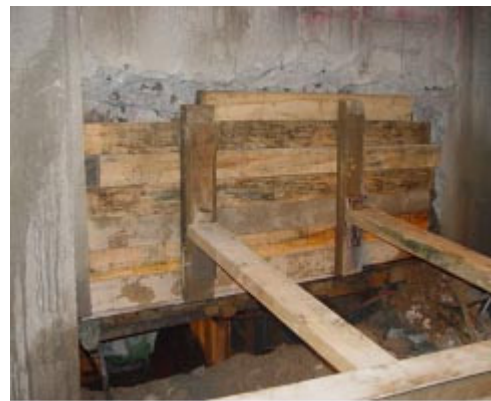
그림 11. 막장막이 설치
