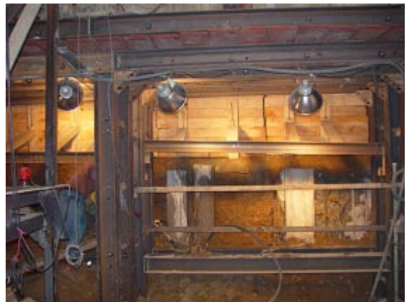
그림 7. 추진기지 설치
