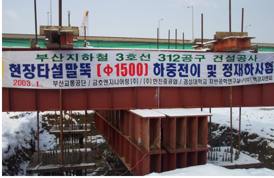
(a) 현장타설 콘크리트말뚝
