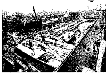
사진 4.11 비우당교 시공 모습(II)
