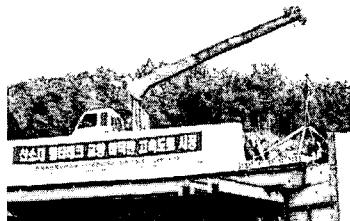
사진 4.2 형주교 시공 모습(II)
