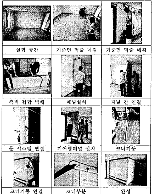
그림6. 안목기준면잡기 설치
