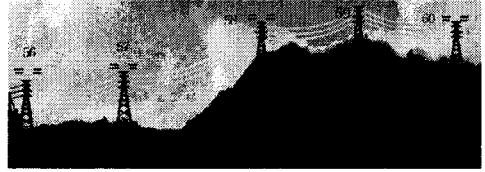
그림 1 갠로핑 발생 송전선로 사진
