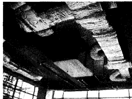
[그림 16 : 히트펌프 설치작업]
