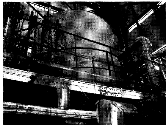
[그림 2 : 100 kW MCFC 시스템 전경 및 스택 ]
