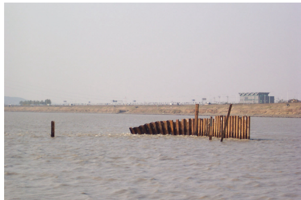
그림 2. 시트파일 사고 사진(좌안에서 바라본 전경)
