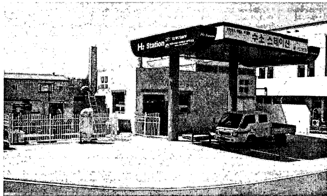
[그림 3] 천연가스 개질형 수소 스테이션 현장 전경
