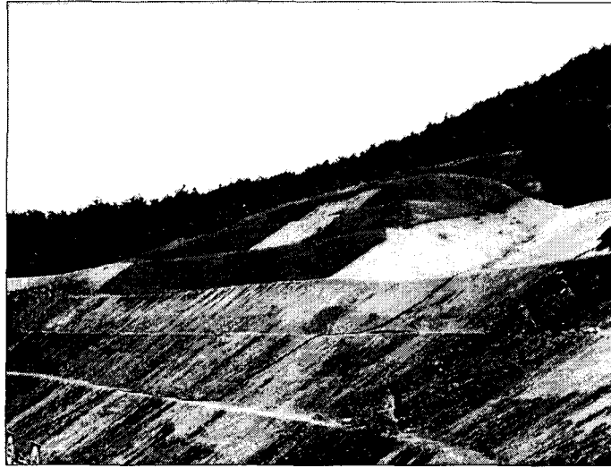
그림 14. 시공 완료후 사면
