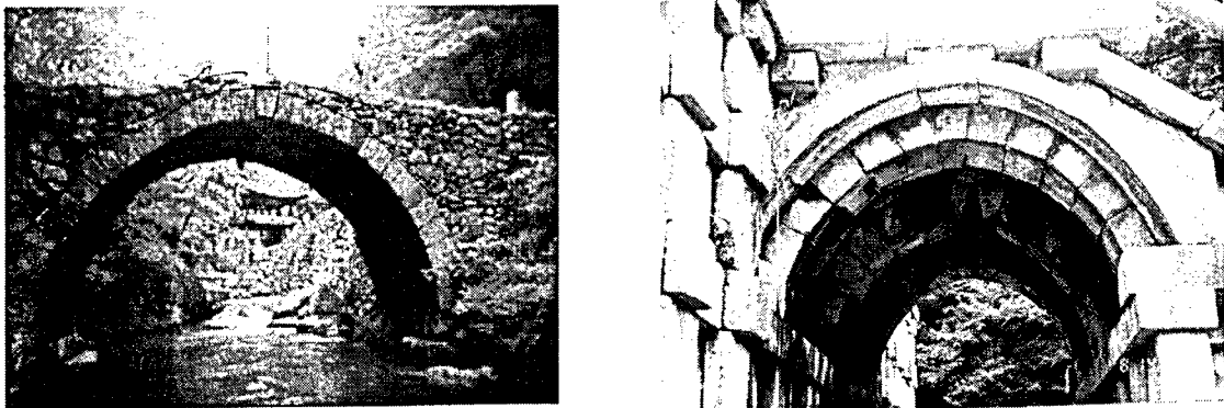
그림 1. 일반적인 구름다리(한 겹 아치)와 불국사 청운교(두 겹 아치)
