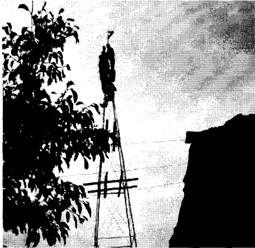
북한의 10KW급 풍력발전 설치장면
