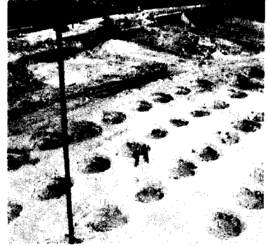
(c) 시공 완료 후
