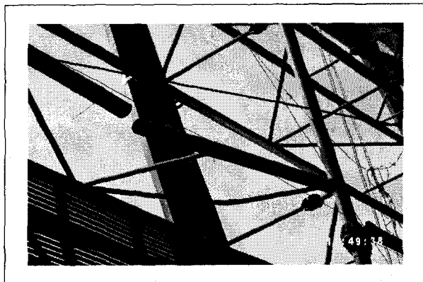
<사진 3> 수평부재 용접접합부 파단상태
