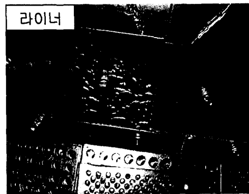
Fig. 1 블라스팅 장비 벽체 라이너의 손상 형상
