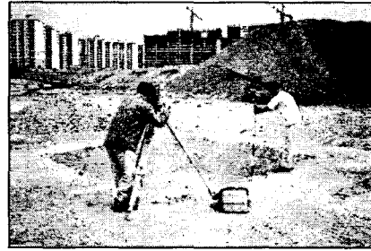
그림 8. T.S를 이용한 지형측량
