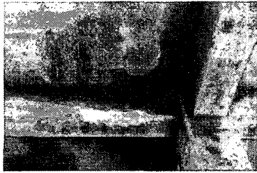
사진 4. 콘크리트 표면의 변색과 폭열상황
