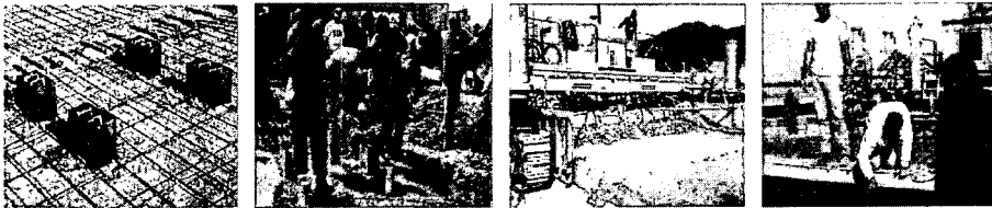
① 변형률계 배치 ② 박스 채움 ③ 콘크리트 포설 ④ 보호박스 제거
