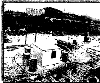
SVE, Bioventing, Hybrid Mobile Remediation System의 복원효율성 비교평가
