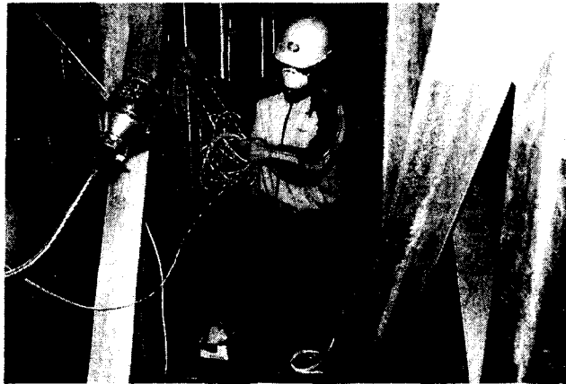
그림 3. 광섬유센서 및 광섬유 리드선의 설치
