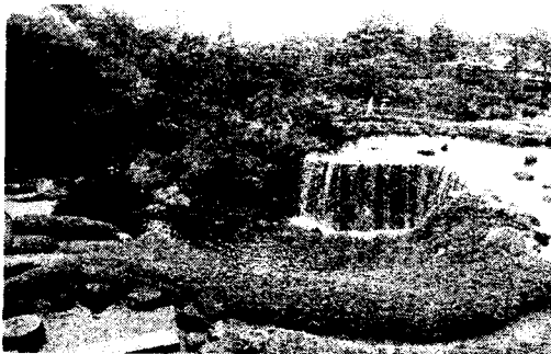
사진 2. 옥상녹화 전경, 일본
