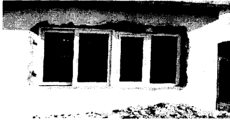
Fig. 1 실험건물의 창문 설치현황
