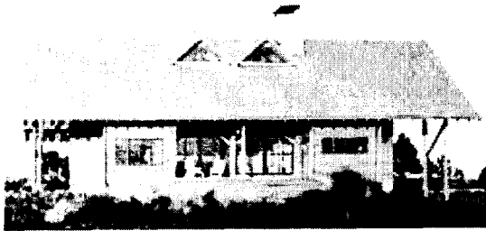
그림 17. 기둥-보 구조가 강조되었으며 건조하고 비옥한 토지에 가볍게 안치시킨 것으로 깊은 처마를 지닌 금속지붕이 바람과 태양, 눈을 잘 가려주도록 설계되었다.(Meghan Drueding, Cheryl Weber, Nigel F. Maynard & Shelley D. Hutchins)
