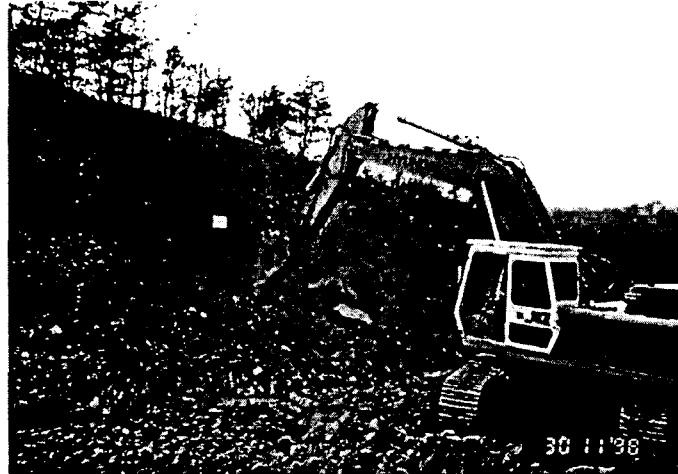
그림 5. 암판정이 애매한 경우 굴삭기에 의한 리핑 가능여부 확인 작업
