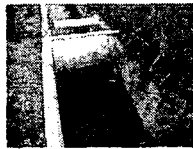
(a) 수문 앞에 오물이 모여있는 모습 (b) 오물유입방지 고무 부착 및 수류상태
