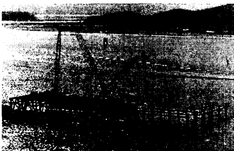
그림 10. Yard 작업대 강관 Pile 항타
