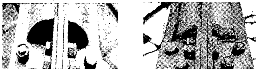
(1) 강관부재 단말부 밀봉 전 (2) 강관부재 단말부 밀봉 후
