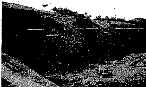
그림 9. 암반 사면붕괴직후의 모습
