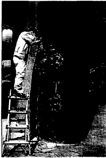
그림 7 초음파 센서 설치장면(고수부 우안)
