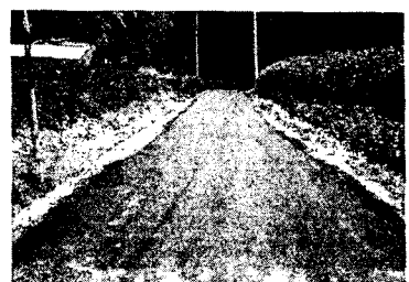
Fig. 6 시험포장 후 도로 전경
