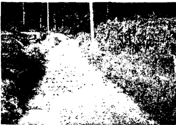
Fig. 1 시험포장 전 도로 전경
