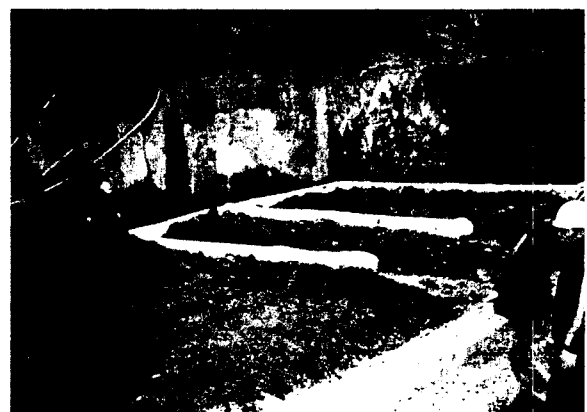
(b) 배수공의 시공
