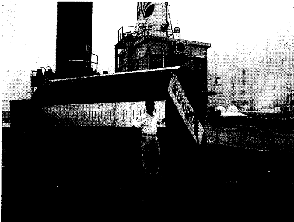
그림-3. (주)대우건설 Suction Pile 현장시험사진
