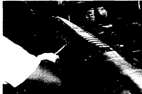
그림 14 콘크리트 접착부 마찰돌기 성형
