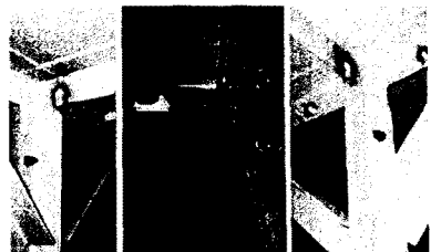
그림 2 패널 발열부분 페인트 변색 상태
