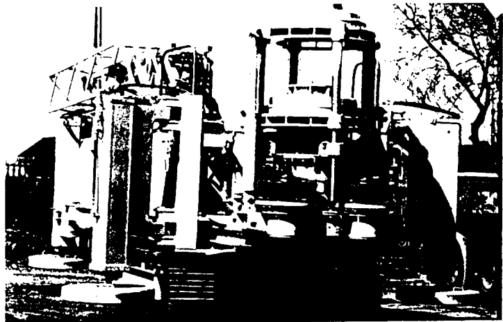
Fig. 44 : Atlas screw pile rig
