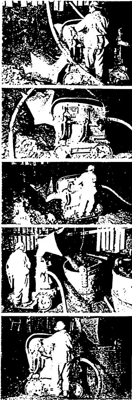
(그림 7) ROCKER SHOVEL에 의한 MUCKING
