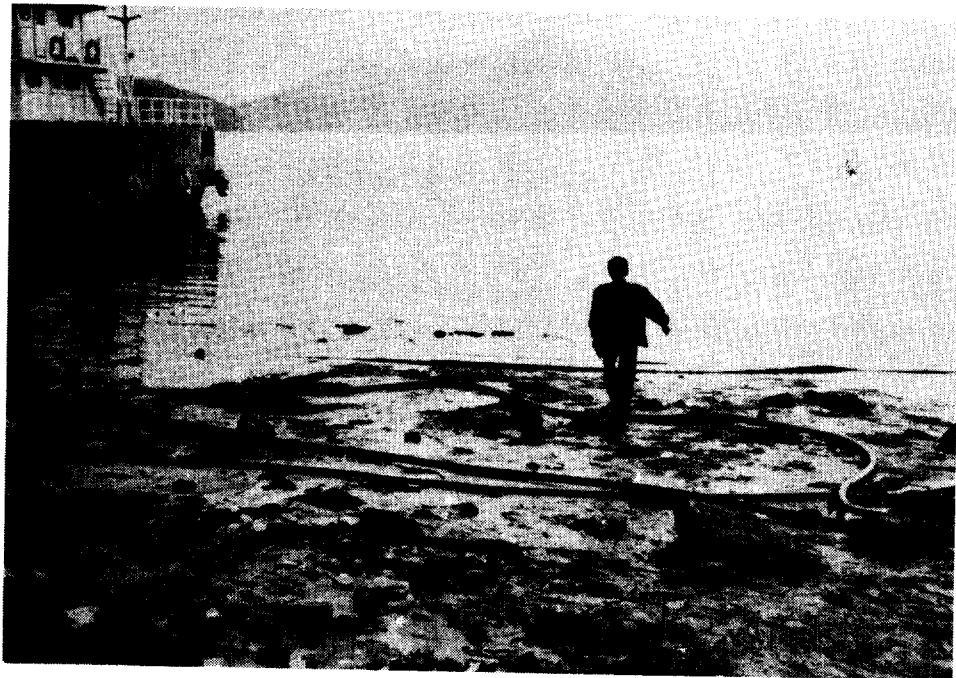
사진-2. 연약지반에 고화재처리 4개월후의 안정된 모습
