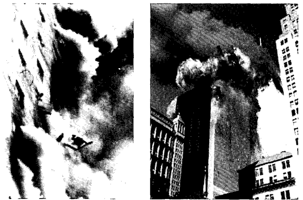
사진 1. 화재로 인한 건축물의 붕괴
