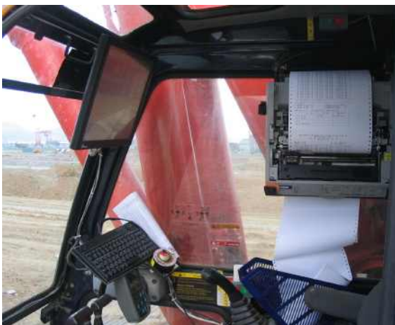
[그림 9] 측정장비가 설치된 PBD 시공장비의 운전석
